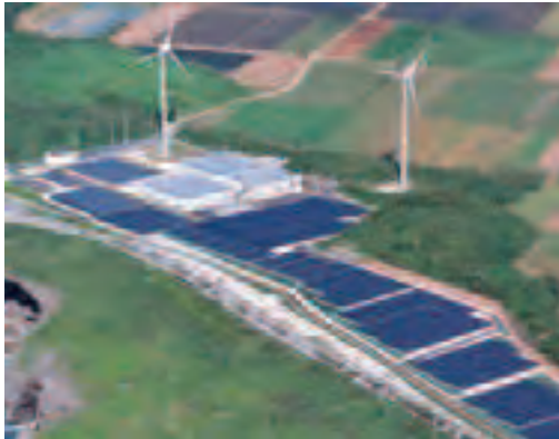
▲環境にやさしい風力・太陽光発電所
