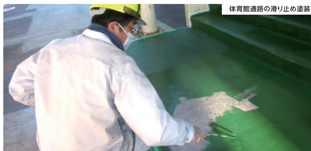
体育館通路の滑り止め塗装
