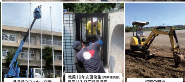
掲揚塔のワイヤー交換
